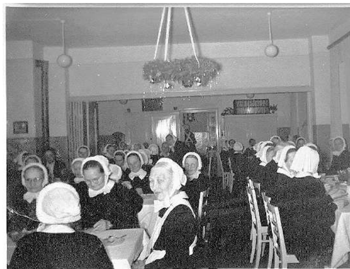
Ein Blick in den Speisesaal des Bugenhagenstifts.
