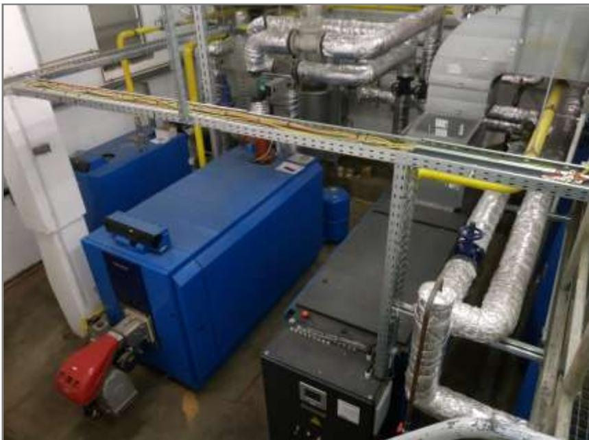
Jahren verschlissen und musste ersetzt werden. Jetzt beziehen wir die Wärme für Heizung und Warmwasser durch ein Blockheizkraftwerk und zwei Gasthermen aus unserem umgebauten Heizhaus.
