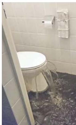
Das Wasser drückte aus der Kanalisation hoch.
